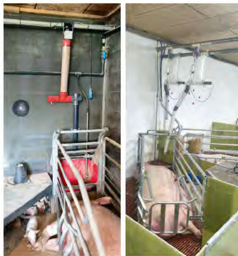
Billede 3: Eksempel på placering af snegl med integreret foderkasse (Foto: BoPil).
