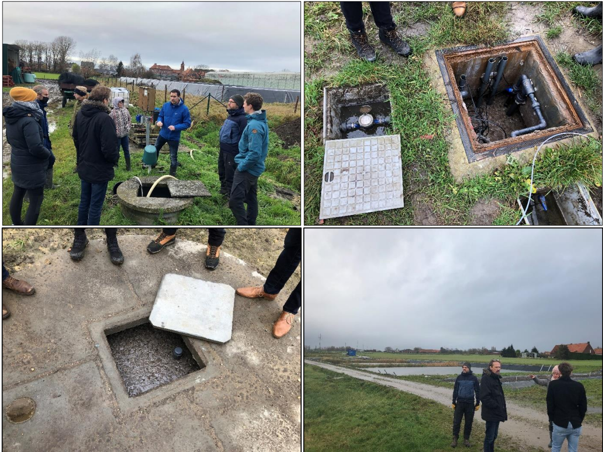
Billedeserie. Øverst til venstre: Pieter Van Aken (i blå jakke) står ved en drænbrønd og fortæller gruppen om MBBR-systemet. Øverst til højre: nærbillede af MBBR-systemet, med flowmåler (til venstre) og udløb (højre hjørne). Nederst til venstre: billede af første kommercielle system, som en gartner har valgt at få etableret på eget initiativ (der er ingen udledningskrav til gartnerier hvad angår kvælstof). Som det ses på billede, så synes MBBR-systemet ikke meget i landskabet. Nederst til højre: belgisk forsøgs-site, hvor danskinspirerende drænvirkemidler testes. Her med en kombination af en filtermatrice og et almindeligt åbent minivådområde. Resultaterne herfra viste en højere nitratfjernelse sammenlignet med danske resultater. I baggrunden anes en blå container, som indeholder et overjordisk MBBR-system, som der også monitoreres på. Foto: Sebastian Zacho, SEGES
