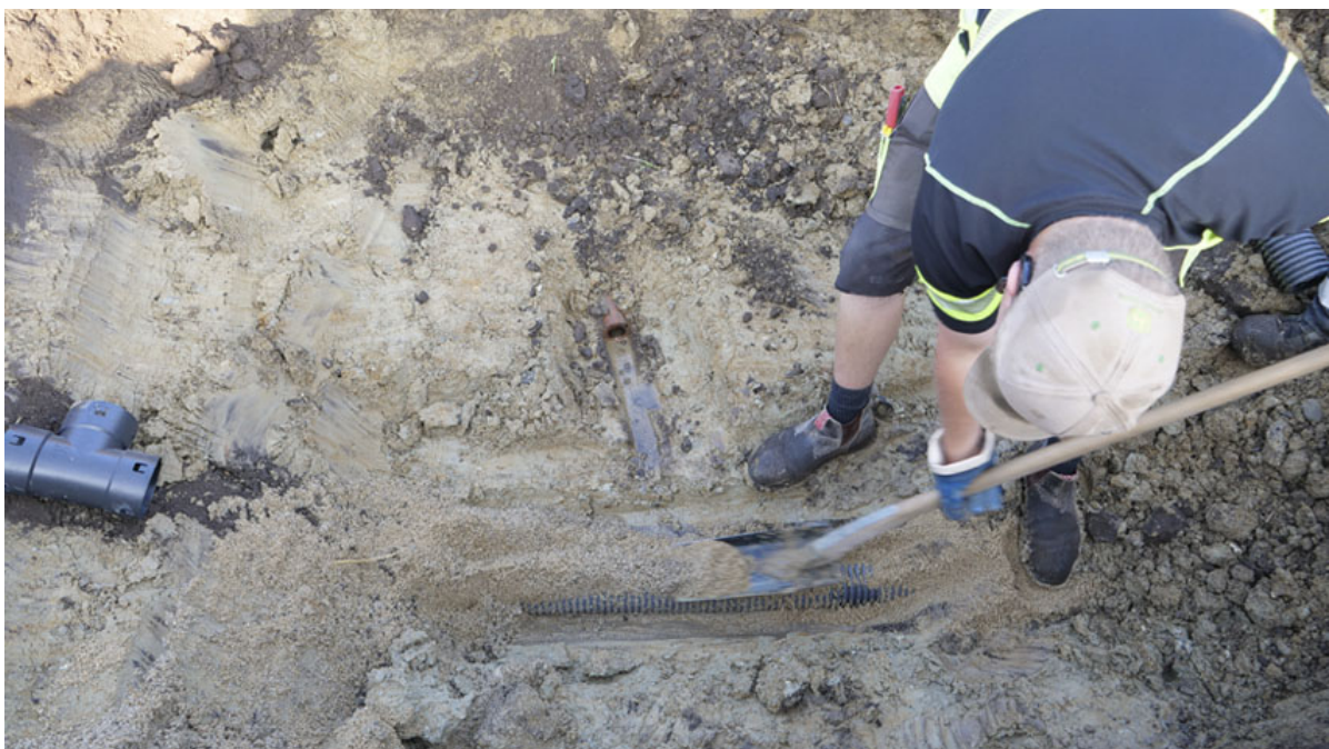
Det nye plastikrør kobles på det gamle lerrør fra 1940'erne og dækkes med filtergrus. Foto: Martin Stoltenberg Hansen.
