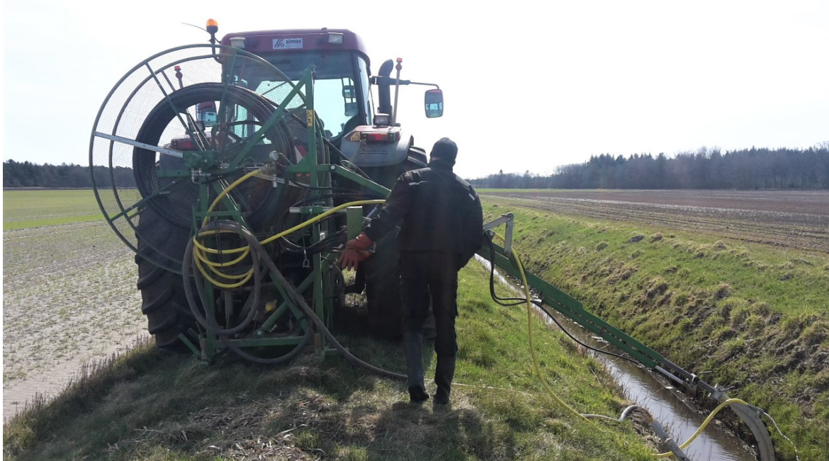
Figur 4.5: Spuling af drænrør i gang. Foto: Stinna Susgaard Filsø.
