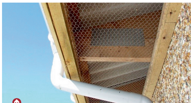
Billede 2. Sørg for at rense staldens udhæng for støv og spindelvæv minimum 1-2 gange årligt. Der skal være 2-3 cm 2 pr. m 3 luft.
