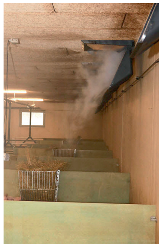
Indstilling af loftventiler, der sikrer, at luften om sommeren ledes direkte ned i grisenes leje.
